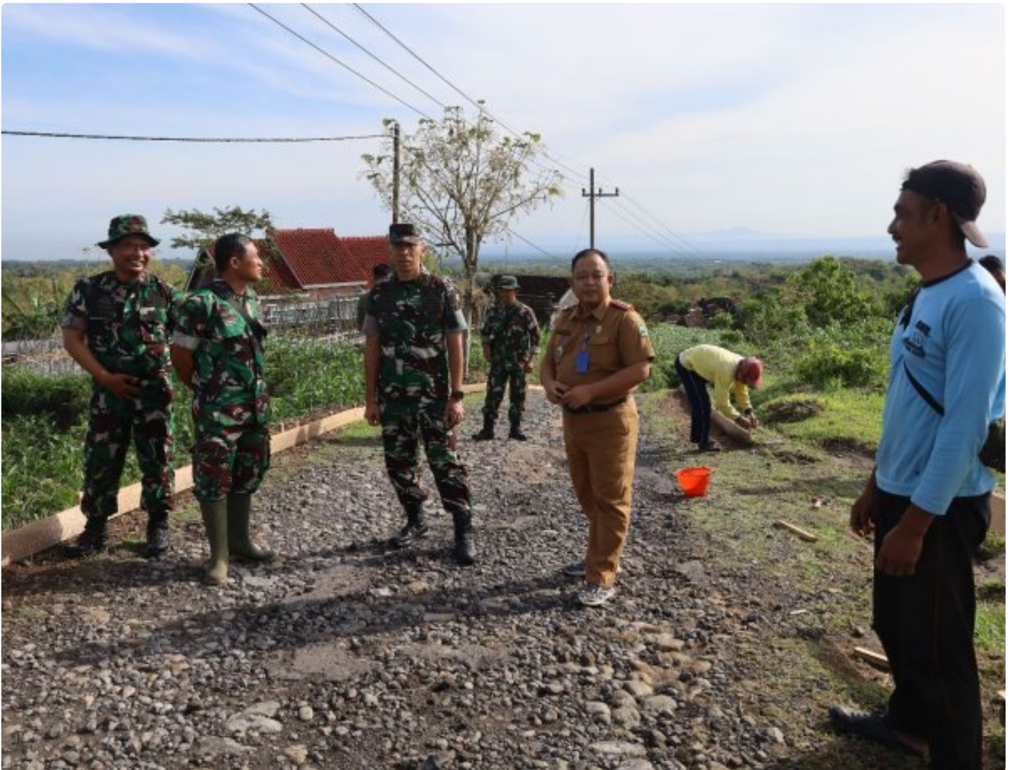
TNI Manunggal Rakyat: Kodim 0804/Magetan Karya Bhakti Pengecoran Jalan
